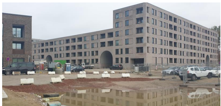
Aktueller Zustand Loki-Schmidt-Platz
